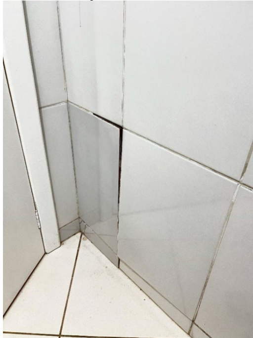
Figura 32 - Deslocamento de azulejos do banheiro feminino do pavimento superior
