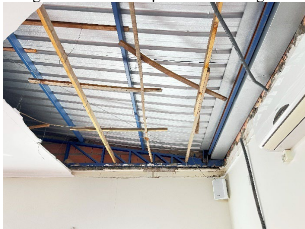
Figura 16 - Sustentação do forro em gesso
