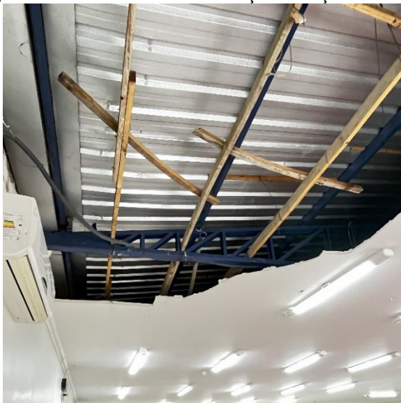
Figura 4 - Distanciamento treliças e terças metálicas
