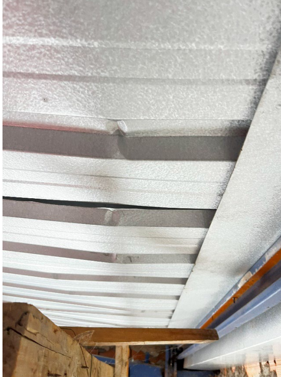
Figura 8 - Deformação telhas metálicas
