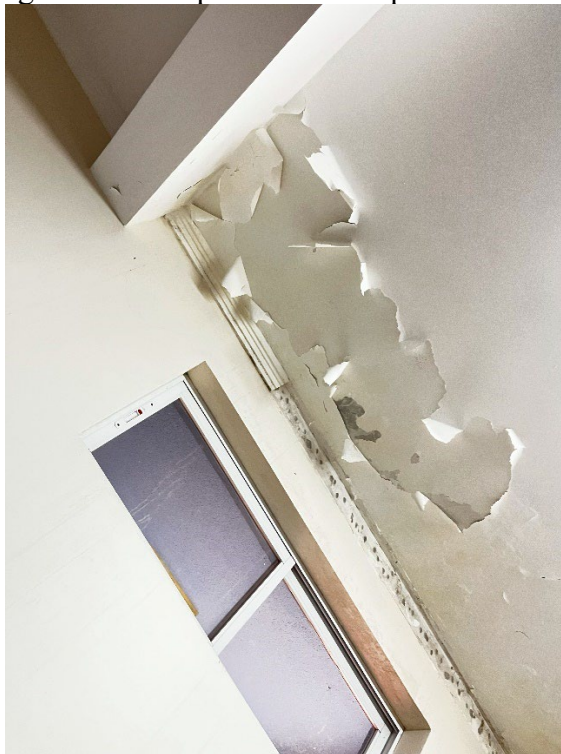
Figura 61 – Deslocamento de pintura em teto
