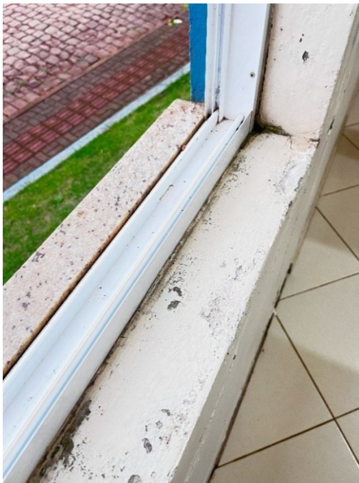
Figura 50 - Vedação e pingadeira ineficiente entre esquadria e alvenaria situada na sala da secretária
