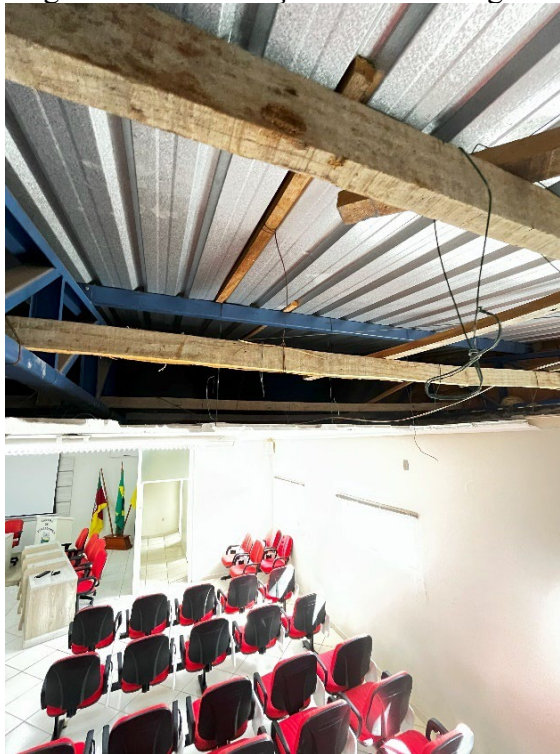
Figura 14 - Sustentação do forro em gesso
