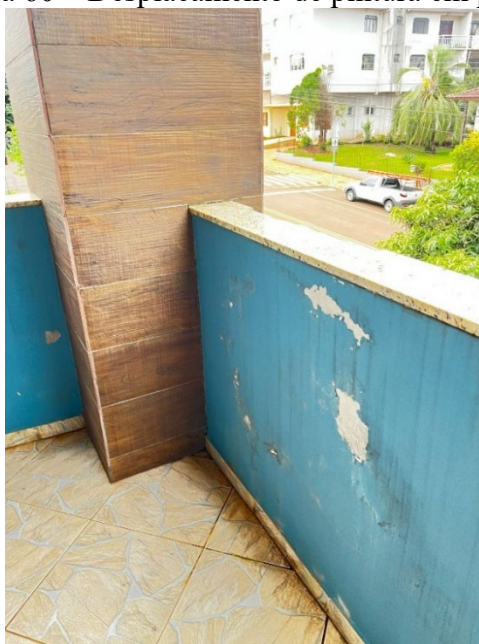
Figura 60 – Deslocamento de pintura em parede
