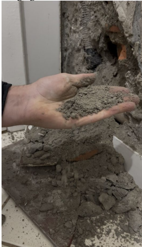
Figura 24 - Emboço desagregado no banheiro feminino do pavimento superior
