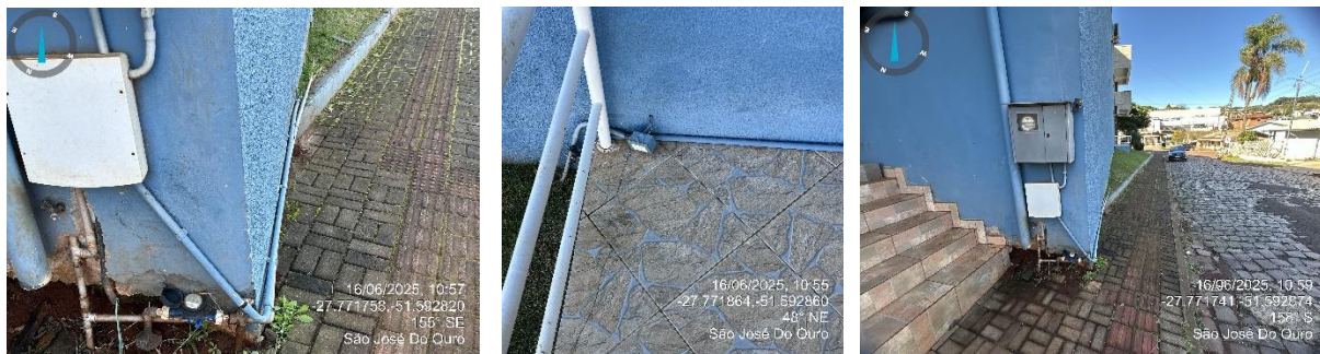
Eletroduto do circuito do elevador externo à edificação.
