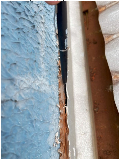
Figura 13 - Vedação da ligação entre a calha e a parede
