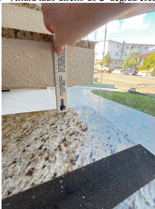
Figura 55 - Altura lado direito do 2º degrau escada
