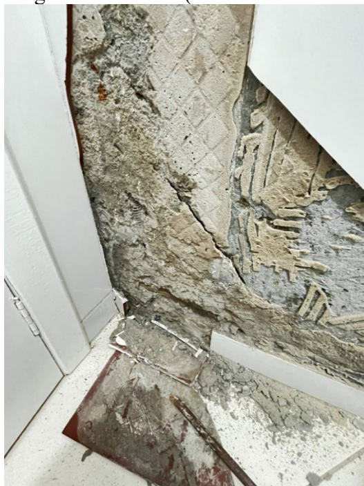
Figura 34 - Cordões de argamassa colante (banheiro feminino do pavimento superior)
