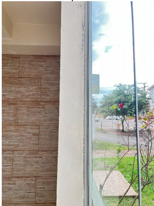
Figura 48 - Vedação ineficiente entre esquadria e alvenaria situada na fachada frontal
