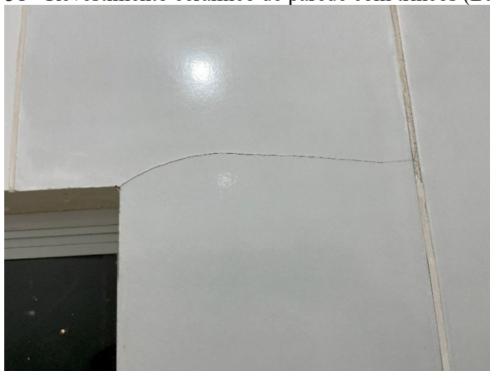
Figura 31 - Revestimento cerâmico de parede com trincos (Banheiro)
