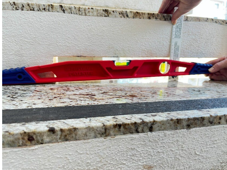
Figura 58 – Aferição do nivelamento dos degraus da escada
