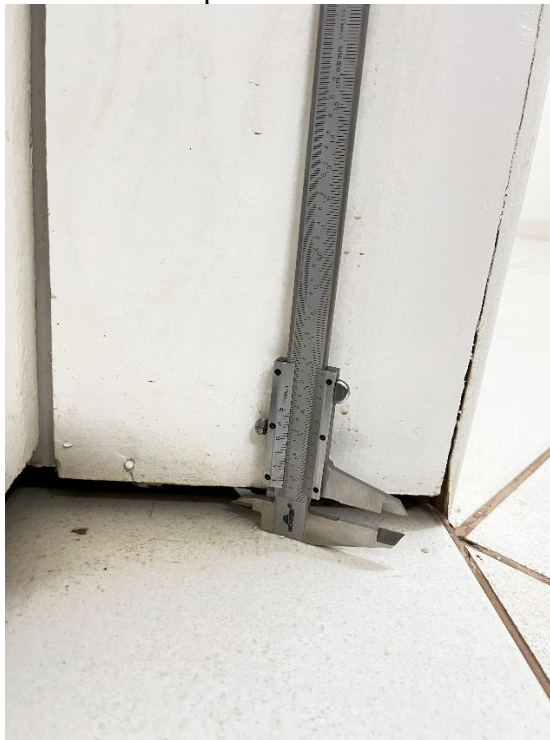
Figura 52 – Frestas em portas de madeira semi-oca internas
