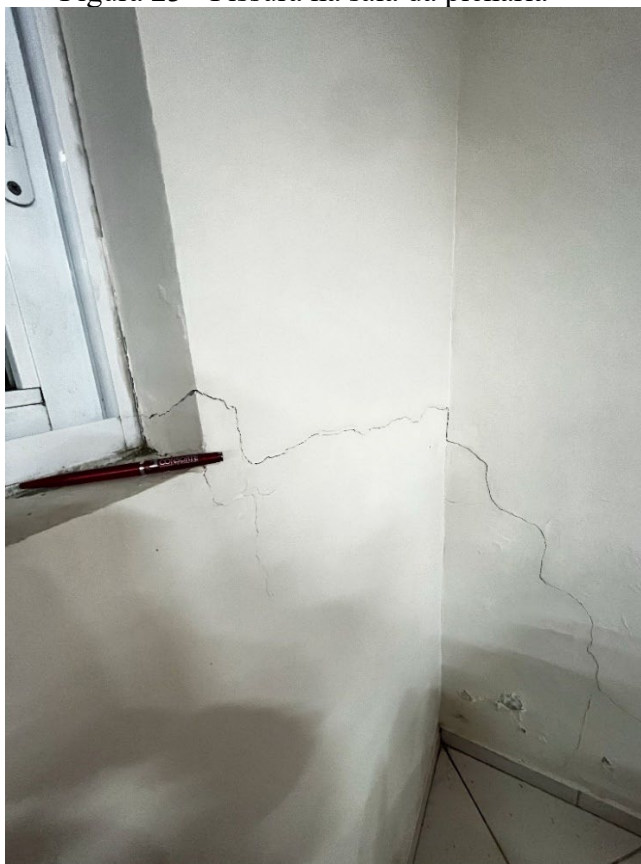
Figura 23 - Fissura na sala da plenária
