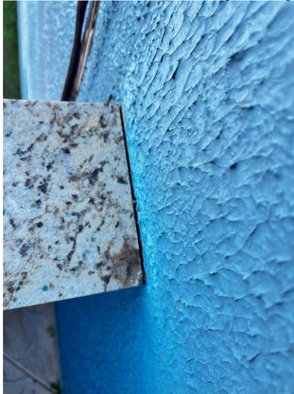
Figura 53 – Inexistência de vedação entre peitoril e parede
