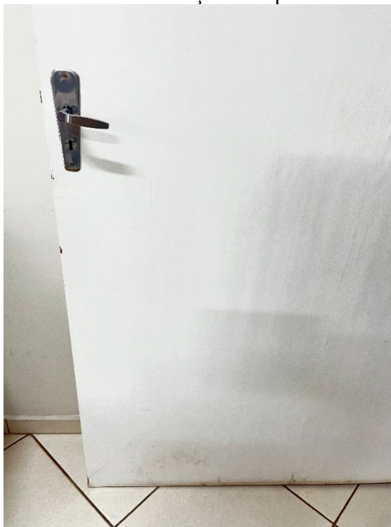
Figura 51 - Porta interna de madeira semi-oca situada na sala da secretária, apresentando sinais de delaminação e empenamento
