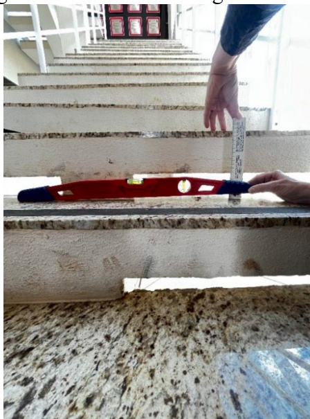
Figura 57 – Nível do 2º degrau da escada
