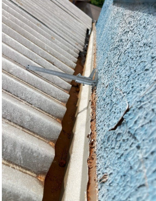
Figura 12 - Calha de construção vizinha ligada a parede externa
