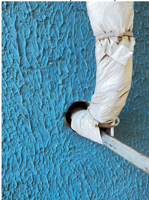
Figura 54 – Inexistência de vedação na tubulação de ar-condicionado
