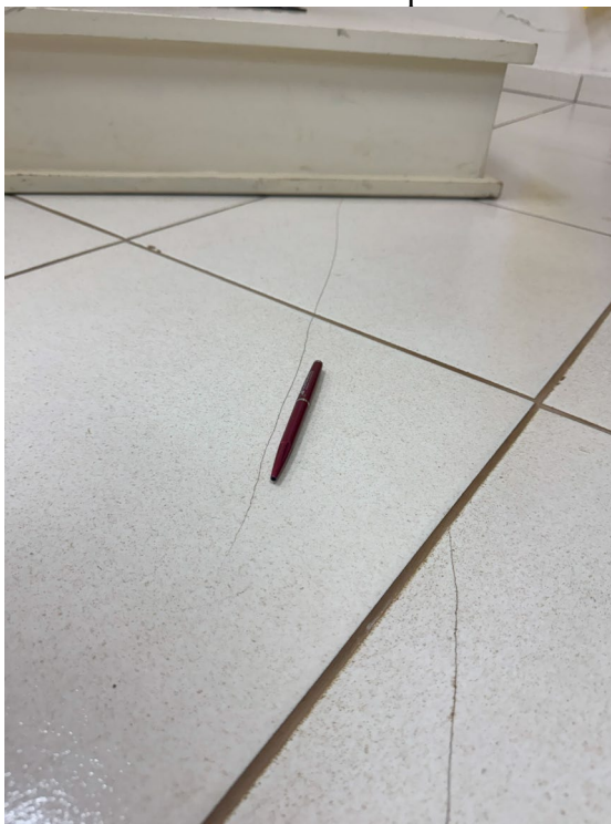
Figura 30 - Revestimento cerâmico de piso com trincos (plenária)
