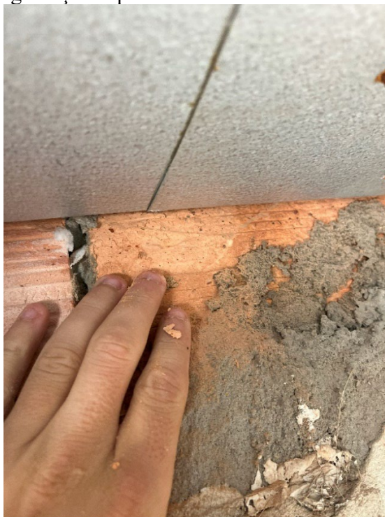
Figura 10 - Degradação superficial dos blocos cerâmicos da platibanda
