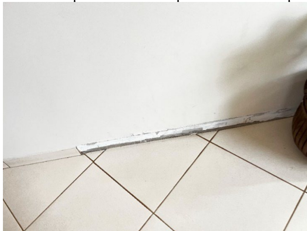
Figura 33 - Deslocamento rodapés cerâmicos no plenário
