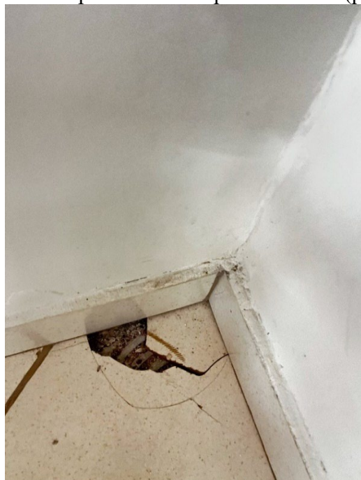
Figura 35 - Deslocamento de piso cerâmico (plenário)
