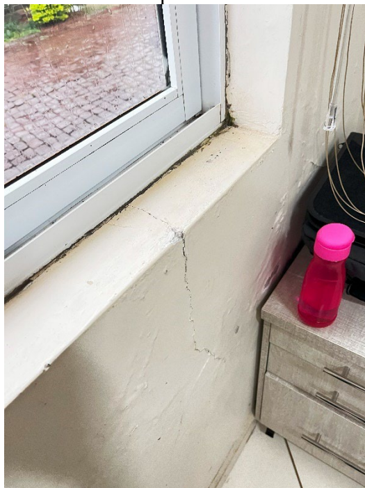
Figura 49 - Vedação ineficiente entre esquadria e alvenaria situada na sala da secretária
