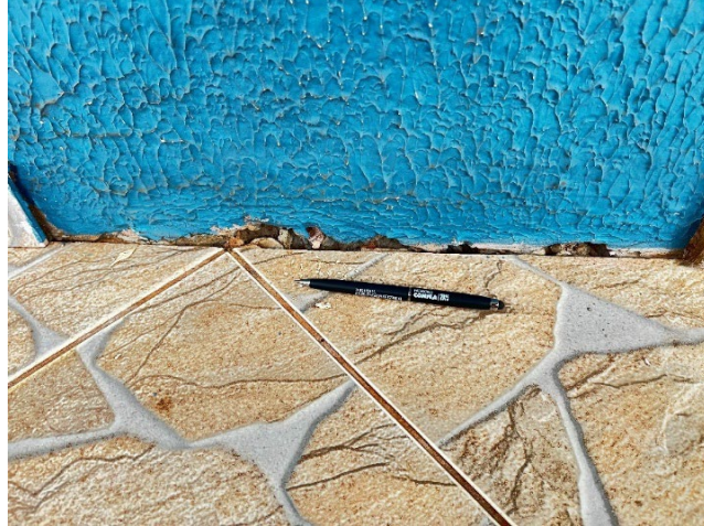
Figura 41 – Ponto de infiltração de água na sacada
