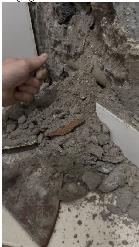
Figura 25 - Emboço desagregado no banheiro feminino do pavimento superior
