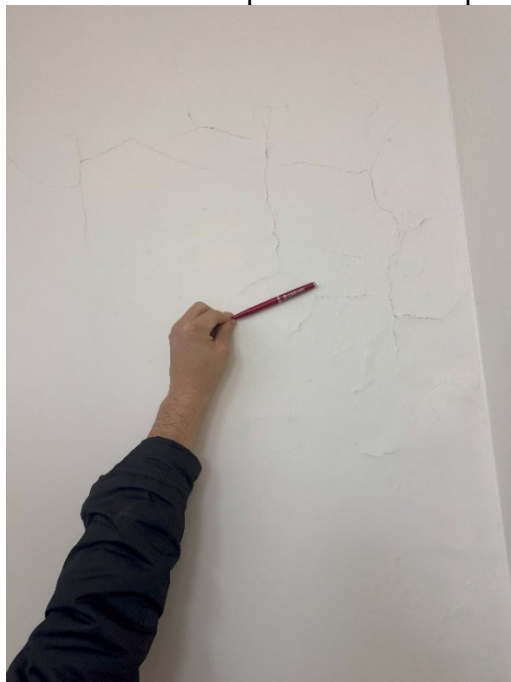
Figura 22 - Fissura mapeada na sala do plenário
