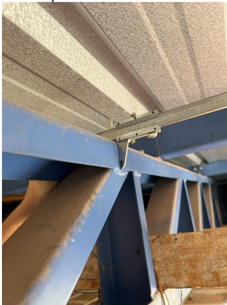
Figura 5 - Aferição das dimensões do banzo superior
